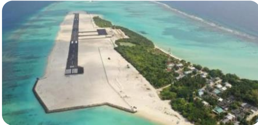
Maavarulu Airport, Gaafu Dhaalu Atoll
